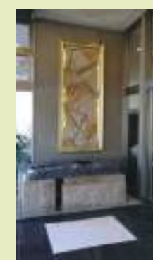
黒御影石、さび石割石加工
